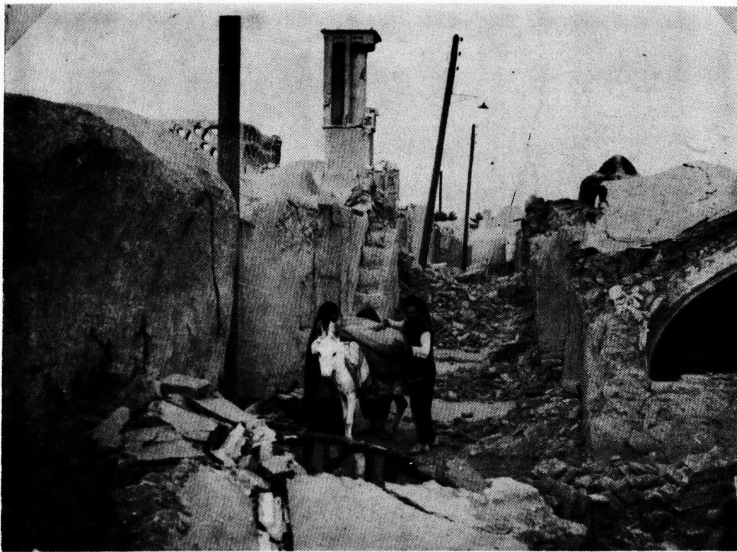
يك خانوار زلزله زد هدر حال انتقال اناثه خود
